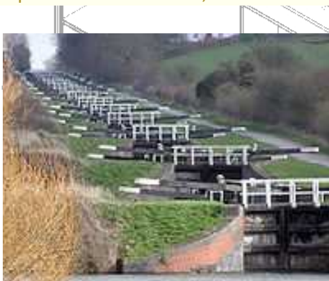
Système d'écluses « en escalier » à Caen Hill (Devizes), sur le canal Kennet-and-Avon, dans le sud de l'Angleterre. Il y a ici 16 écluses séparées par de très courts biefs pour permettre le croisement des bateaux.
